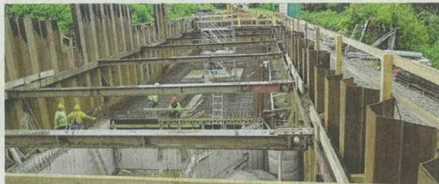
Neubau eines Regenüberlaufbeckens
