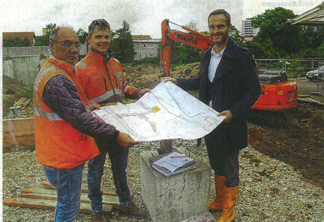
Joachim Eichele, Matthias Kolb und Bürgermeister Frederick Brütting (von links) mit den Plänen fürs Gelände Triumph Werk II: Dort werden in den kommenden Wochen Leitungen verlegt, und die Straße „An der Weberei“ entsteht. Foto: Tom
